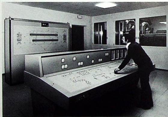
Blick in die Elektrozentrale des neuen Flughafens Berlin-Tegel mit Steuerpult und Symbolbild der gesamten Befeuerungsanlage
